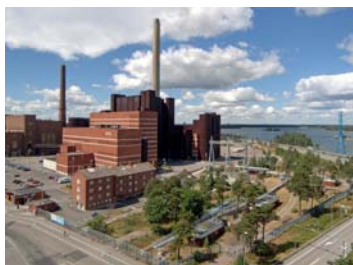
Salmisaari CHP -laitos (photo: Juhani Eskelinen)
